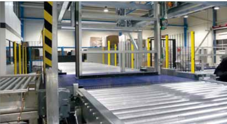
Transportanlage für Wälzlager -> 3,5t
